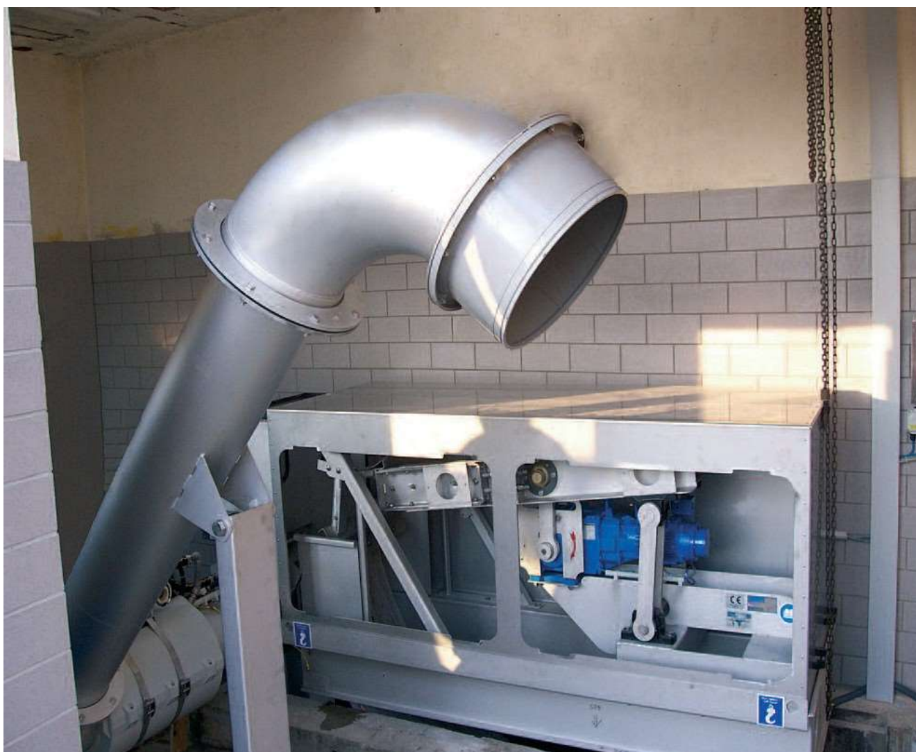
Индивидуално съобразяване със съществуващите съотношения заедно с компактна конструкция характеризират HUBER Плоскоситова ротационна решетка CurveMax®
