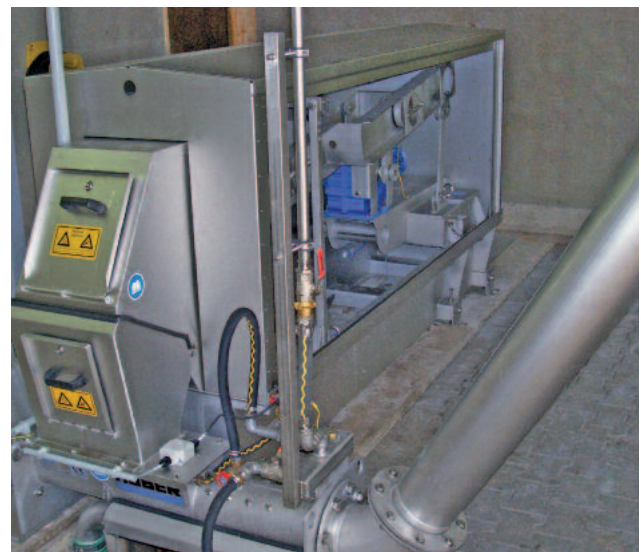
Gerinneeinbau des HUBER Flachsieb-Umlaufrechen CurveMax® mit nachgeschalteter Waschpresse
