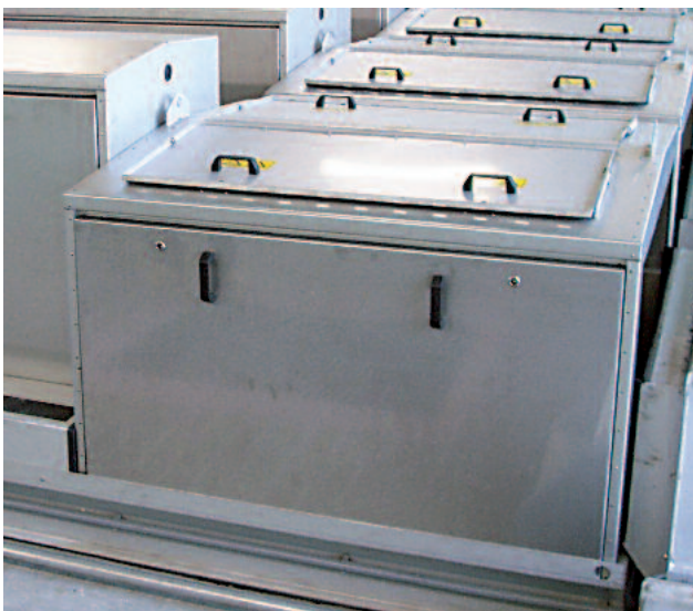
Mehrere parallel installierte HUBER Flachsieb-Umlaufrechen CurveMax® mit geruchsgekapselter Abdeckung
