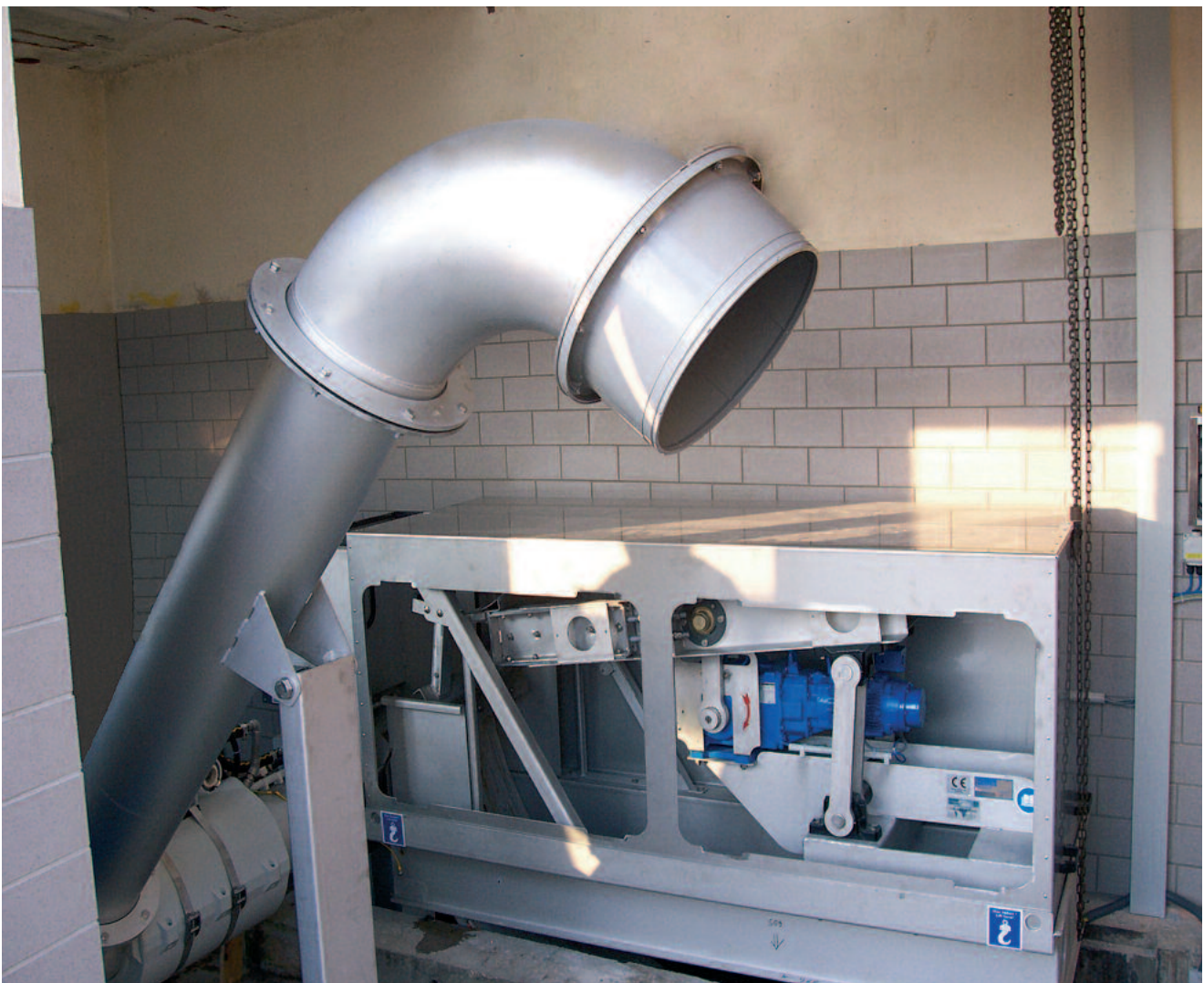
Individuelle Anpassung an bestehende Verhältnisse vereint mit kompakter Bauweise zeichnen den HUBER Flachsieb-Umlaufrechen CurveMax® aus.
