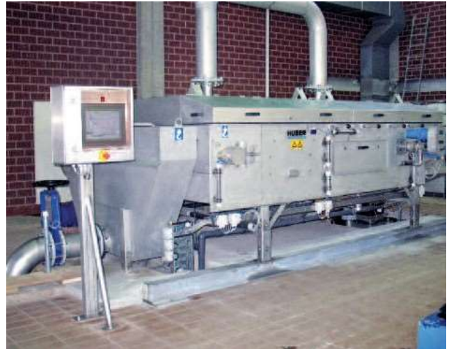
HUBER Лентов състител DrainBelt за до 100 м 3 /ч редки утайки
