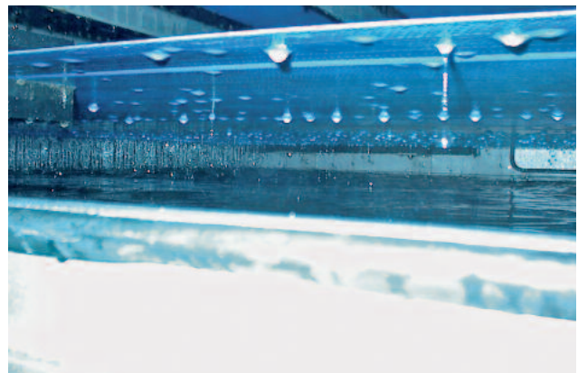
Blick in den Filtratraum
