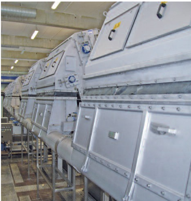
HUBER ротационната решетка EscaMax® - изглед отзад с включен след нея воден улей за транспорт на отсятата маса без износване
