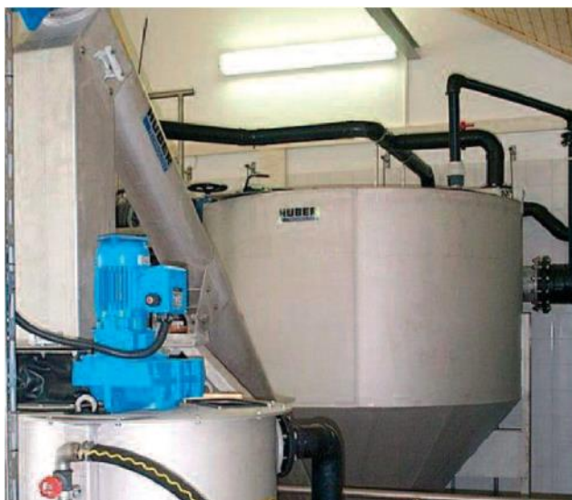
HUBER Радиален пясъкоуловител HRSF с интегриран класифициращ шнек и включено след него HUBER Съоръжение за промиване на пясък RoSF4 T
