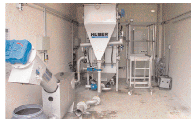
Месарница Walk / Германия: Месопреработка, Пресяващ шнек ROTAMAT® Ro 9 в резервоар, Напорен флотатор HUBER HDF-1 без химическо стъпало, производителност: до 10 м³/ч
