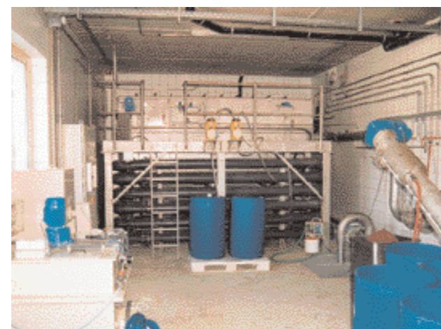
Кланница Инголщадт / Германия : Снимка горе : Пресяващ шнек ROTAMAT® Ro 9, напорен флотатор HUBER HDF-3 с химическо стъпало , производителност: 30 м³/ч
