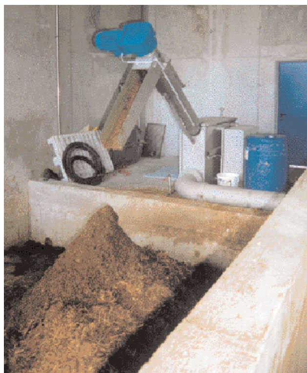
PEPSICO / Аржентина: Преработка на хранителни продукти, Шнекова преса ROTAMAT® RoS 3, производителност: 5 - 10 м³/ч
