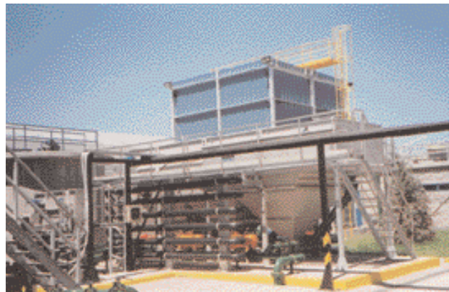
PEPSICO / Аржентина: Преработка на хранителни продукти, Пресяващ шнек ROTAMAT® Ro 9, Напорен флотатор HUBER HDF-75 с химическо стъпало, производителност : 70 - 80 м³/ч
