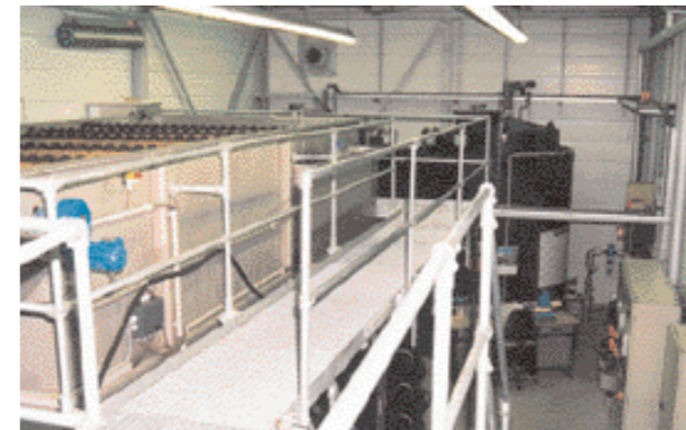
Кланница Хинвил/Швейцария, сито ROTAMAT® Ro2, Напорен флотатор HUBER HDF-50 с химическо стъпало , производителност: 50-60м³/ч, Шнекова преса ROTAMAT® RoS 3, производителност: 5 м³/ч
