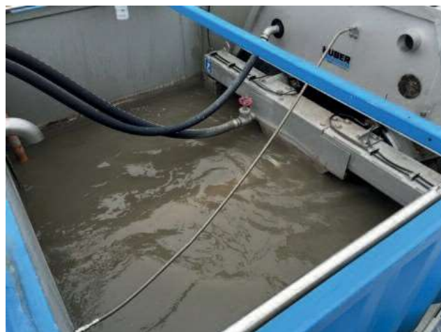
HUBER Барабанно сито LIQUID за много високи степени на сепарация при същевременно минимални загуби на налягане.
