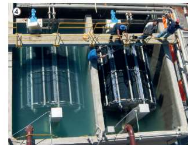
Мембранен филтрационен агрегат HuberVRM® за задържане на бактерии, вируси и микроорганизми, големина на порите 0,038 μm. Отпадъчната вода дифузира посредством генериран от помпа вакуум през мембраната.
