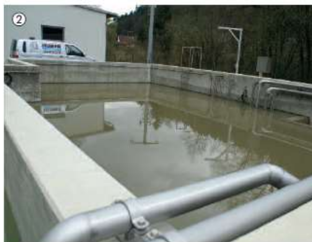
Буферен резервоар за поемане на хидравлични пикове и натоварвания, грубо аериран или с бъркалка
