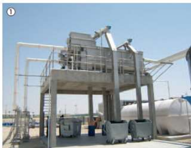
Механично предварително пречистване 3мм сито с кръгли отвори или 1мм процели както и пясъко- и мазноуловител
