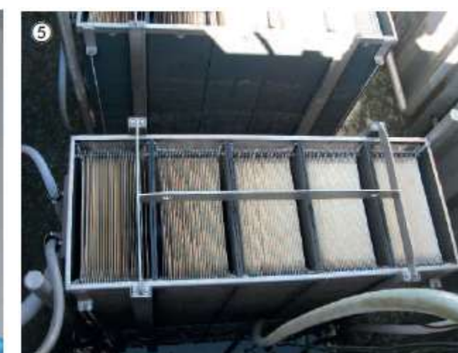
Мембранен филтрационен агрегат HUBERBioMet® като децентрализирано решение инсталиран в контейнер
