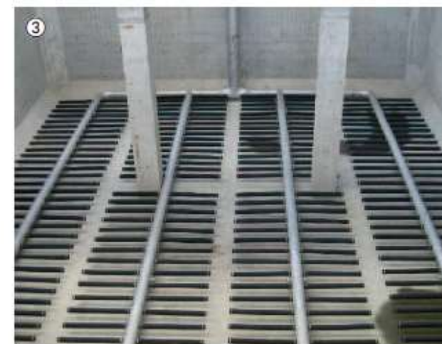
MBR-биология с аерация с фини мехурчета, по технологико-техническо изчисление
