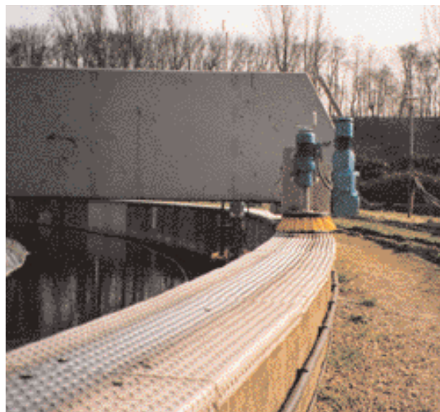
Покритие корона на басейн за радиален басейн от грапава ламарина от неръждаема стомана
