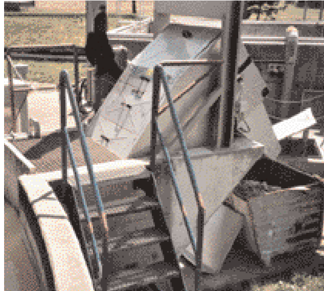
Фабрика за хартия MD Papier Plattling, Германия: Пречистване от твърди и плаващи частици с фина решетка HUBER STEP SCREEN® SSF
