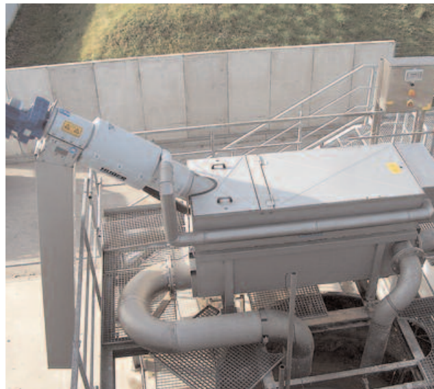
Фабрика за хартия в Германия, сепарация на твърди частици с фина сито HUBER ROTAMAT® Ro 2
