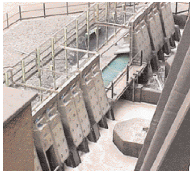
Пречистване на речни води преди охлаждащите турбини с фина решетка HUBER STEP SCREEN® SSV, в Сасол Южна Африка
