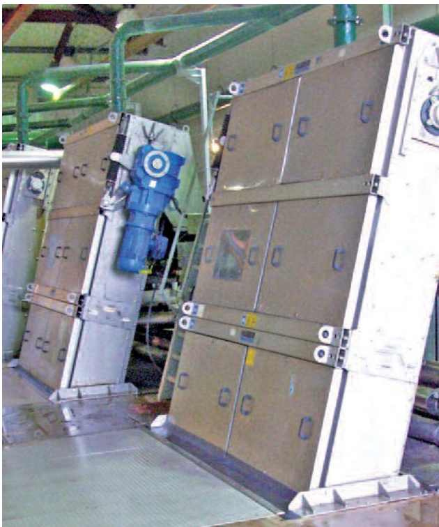
Huber RakeMax®- една универсално приложима греблова ротационна решетка, както за големи ширини на канала ...
