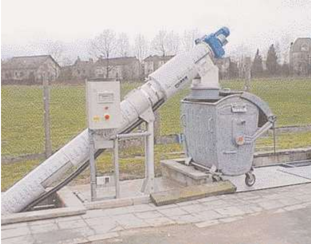
Инсталация на открито HUBER Фина решетка ROTAMAT® Ro1 с устойчиво на зимни условия отопление
