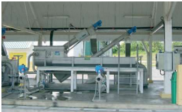
ROTAMAT® Приемна станция за фекални утайки с неаериран пясъкоуловител и интегриран класифициращ пясъка шнек
