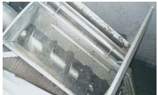
В решетъчния кош се задържат ефективно плаващи и утаечни частици. Чрез проникващите решетъчни зъбци се извършва принудително почистване на решетъчния кош.
