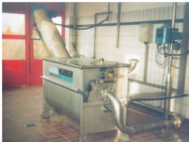
ROTAMAT® Приемна станция за фекални утайки Ro 3.1 с фина решетка ROTAMAT®
