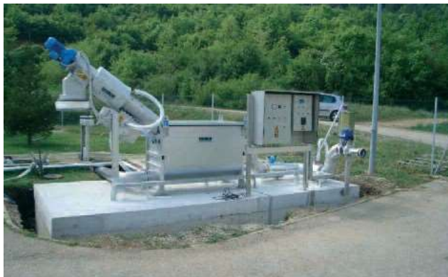
Доказани компоненти са обединени в приемната станция за фекални утайки ROTAMAT® Ro 3.3.
