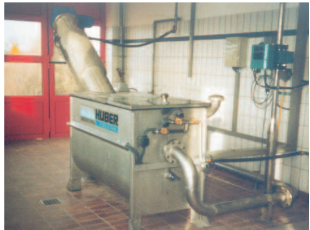
ROTAMAT® Fäkalannahmestation Ro 3.1 mit ROTAMAT® Feinstreichen
