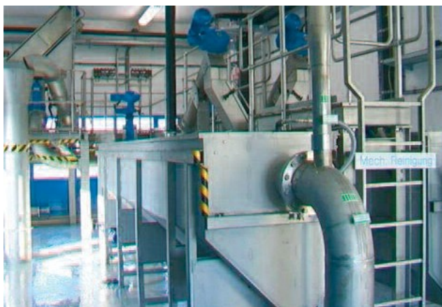
Надземен, редувант HUBER Надлъжен пясъкоуловител ROTAMAT® Ro6
