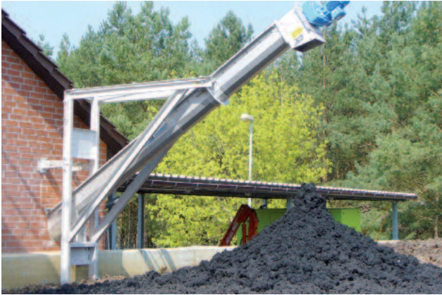
HUBER ROTAMAT® Trogförderschnecke Ro 8t nach der Schlammwässerung
