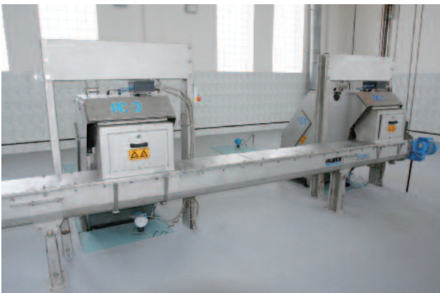
Förderung von Rechengut mit zwei parallel einwerfenden Rechen
