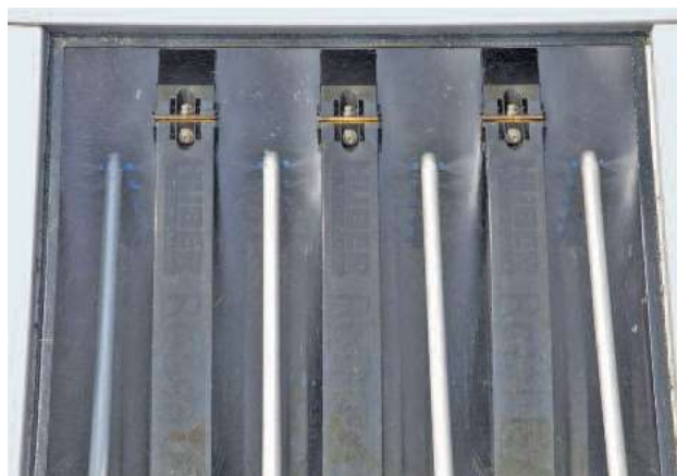
Обратната промивка на дисковете се извършва с филтрат – не е необходимо външно водоподаване
