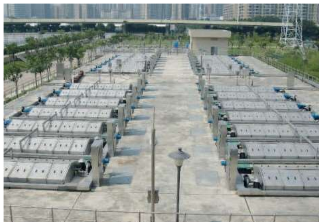
28 Дискови филтъра RoDisc® с по 24 диска пречистват точно 8,5 м 3 отпадъчна вода на секунда
