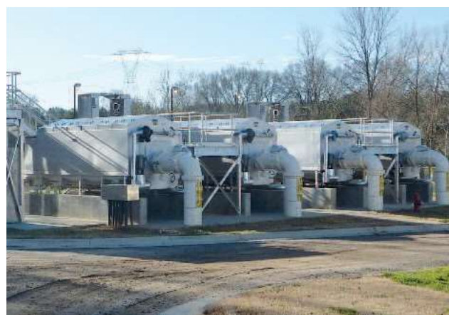
4 Дискови филтъра RoDisc® с 18 диска в резервоар от неръждаема стомана
