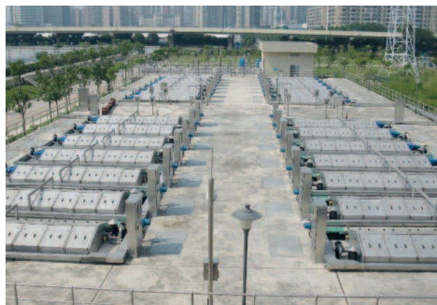
28 RoDisc® Scheibenfilter mit jeweils 24 Scheiben reinigen knapp 8,5 m 3 Abwasser pro Sekunde
