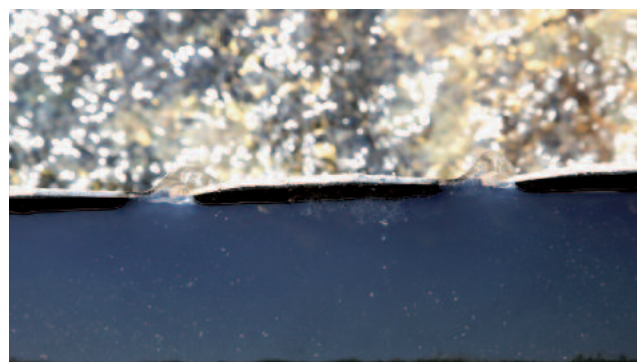
Belebtschlammflocken können im Nachklärbecken oft nicht ausreichend zurückgehalten werden
