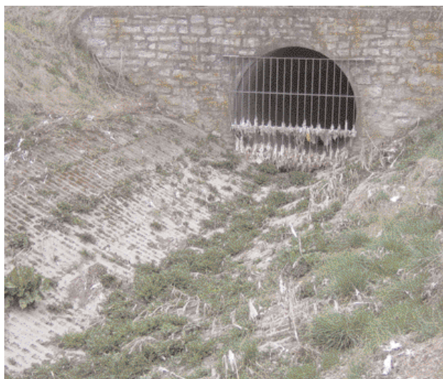
Типична гледка на дъждоизпускателна конструкция без задържане на груби частици процес на изпускане
