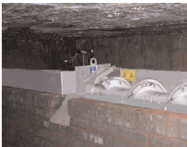
Стандартно връщане на отсятата маса в канала с отпадъчни води с разтоварващ клапан
