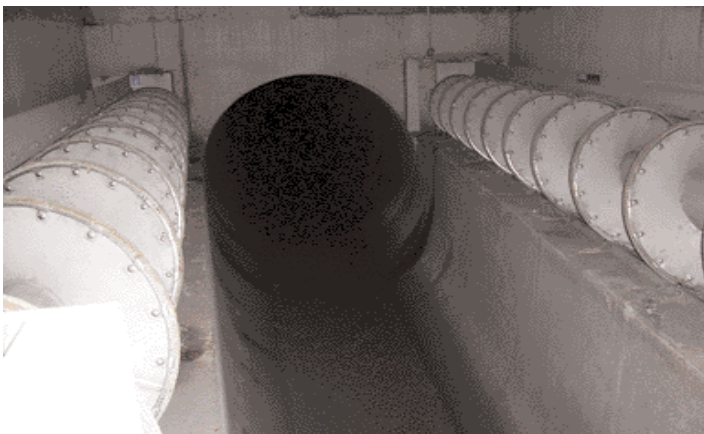
Оборудване на двустранен преливник със сита ROTAMAT® RoK 1 60°
