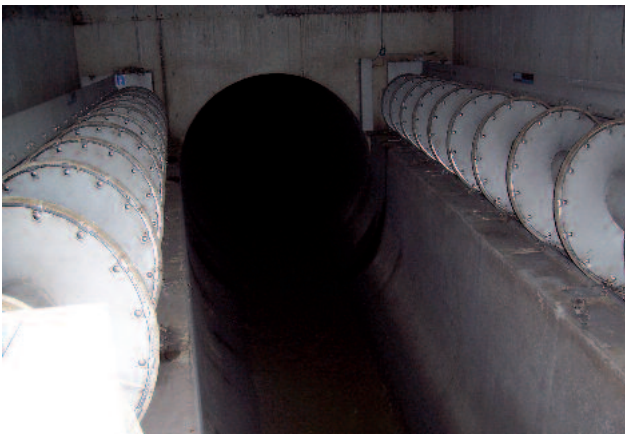
Ausrüstung eines beidseitigen Überlaufes mit ROTAMAT® Siebanlagen RoK 1 60°
