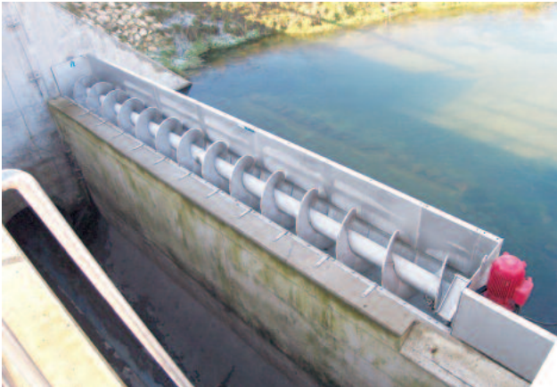
ROTAMAT® Siebanlage RoK 1 an einer Entlastungsschwelle
