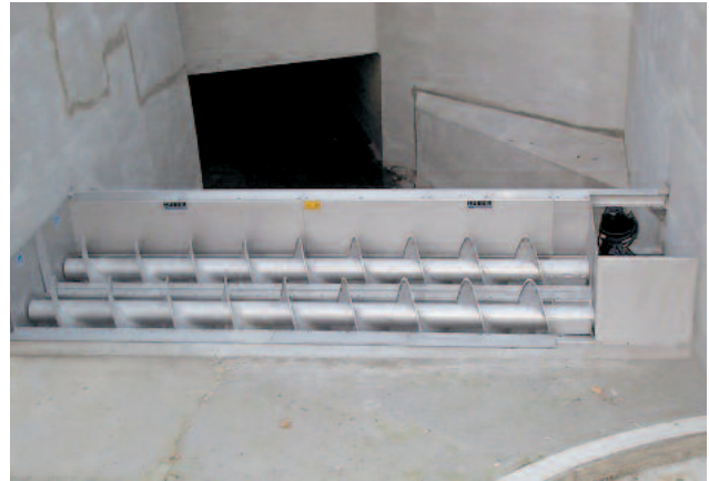
Kombination von 2 ROTAMAT® Siebanlagen RoK 1 für große Entlastungsmengen
