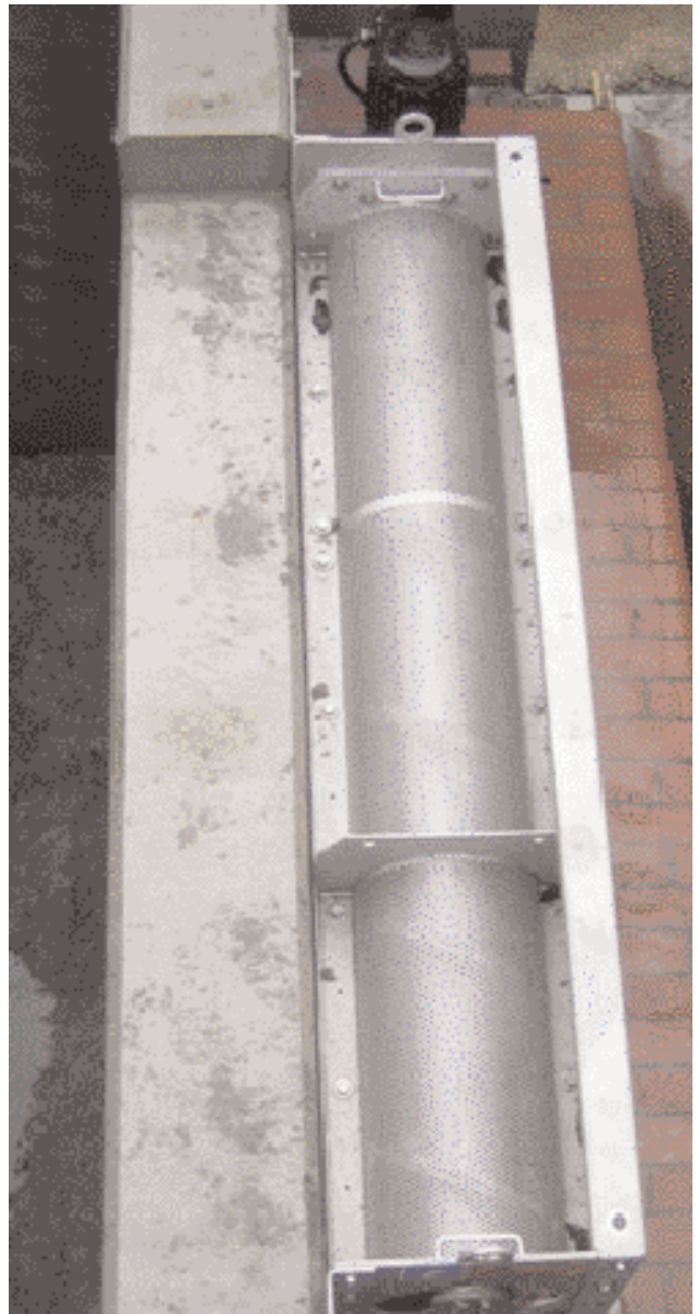
Приложение на сито ROTAMAT® RoK 2 в изпускателна конструкция
