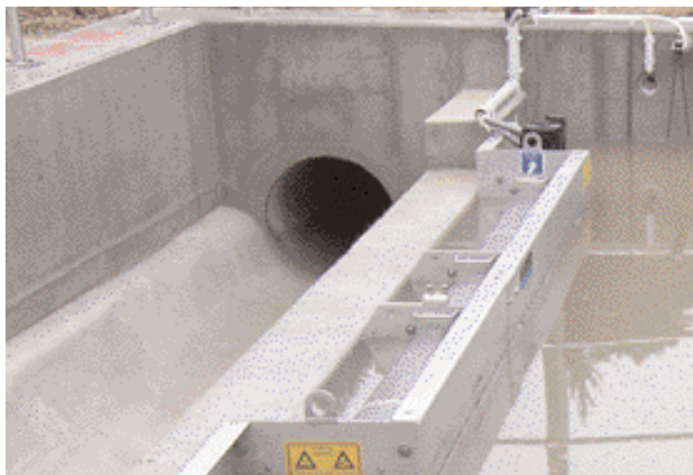
Сито ROTAMAT® RoK 2 преди началото на изпускане
