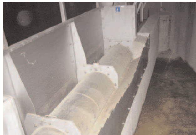
Сито ROTAMAT® RoK 2 с интегриран мерителен савак за измерване на изпусканото количество
