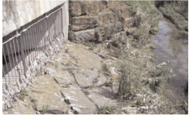
Типична гледка на дъждоизпускателна конструкция без задържане на груби частици след процес на изпускане
