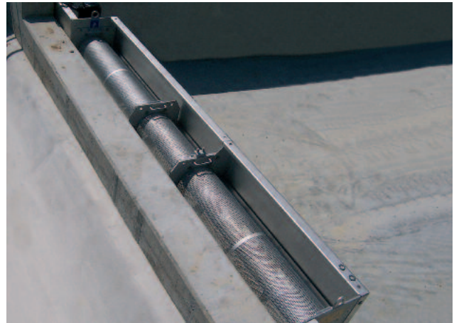
ROTAMAT® Siebanlage RoK 2 nach erfolgter Montage
