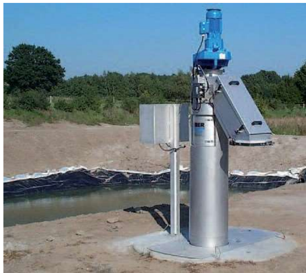
Приложение на вход пред обогатителна пречиствателна станция
