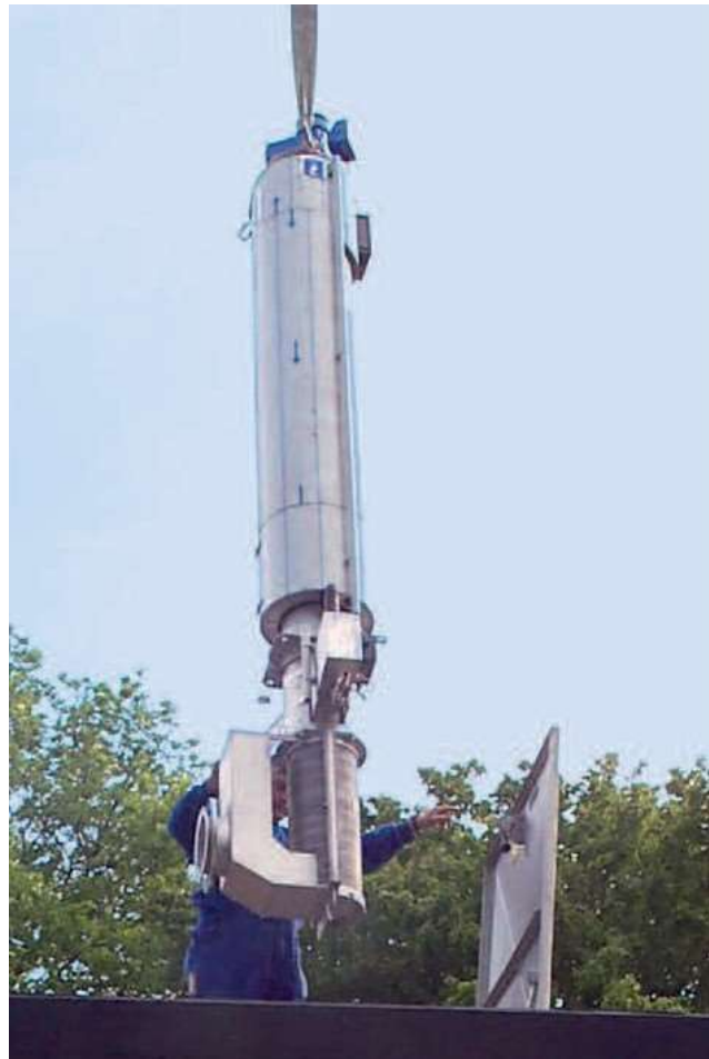
Повдигане на HUBER Шахтово сито ROTAMAT® RoK4 в помпена станция
