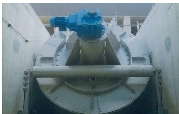
RPPS Star liquid mit dem Durchmesser 2400 mm zum Schutz nachgeschalteter Membrananlagen. Baugrößen bis 3000 mm Durchmesser sind möglich.
