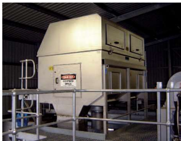
Най-фин пресяващ барабан HUBER RoMesh® - приложение за третиране на отпадъчни води в промишлеността
