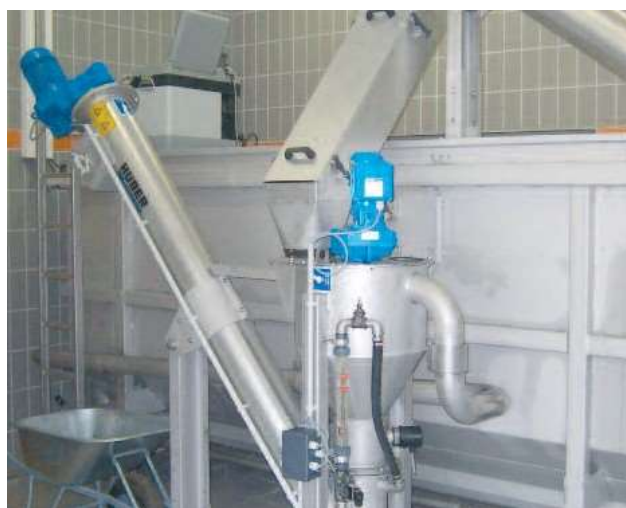
Малко HUBER Съоръжение за промиване на пясък RoSF4 TC промива класифициран пясък от едно HUBER Ккомпактно съоръжение ROTAMAT® Ro5
