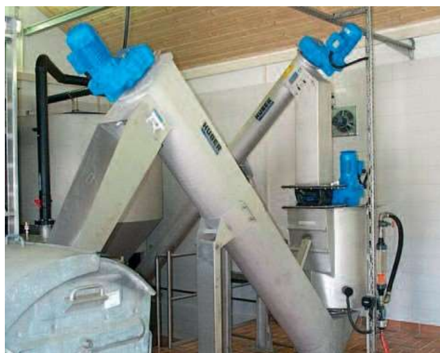
HUBER Съоръжение за промиване на пясък RoSF4 T промива класифициран пясък от един радиален пясъкоуловител HUBER HRSF
