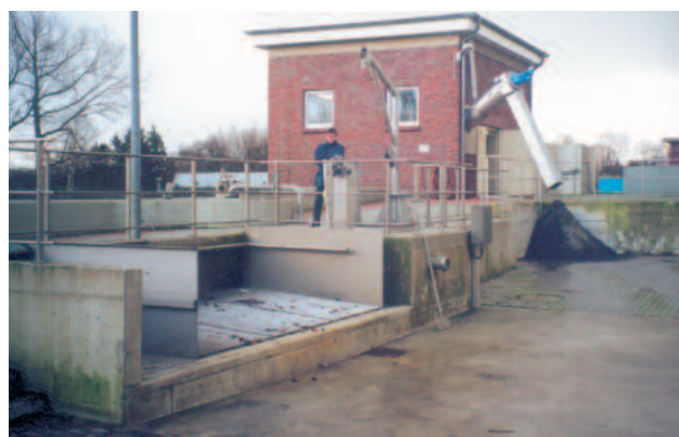
Kein Problem sind große Distanzen zwischen Bunker und Sandwaschanlage
