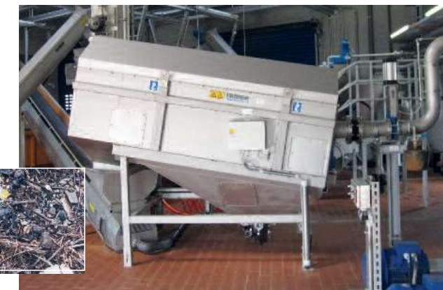
Промиване и отделяне на всички груби частици > 10мм с HUBER Промивен барабан RoSF9
