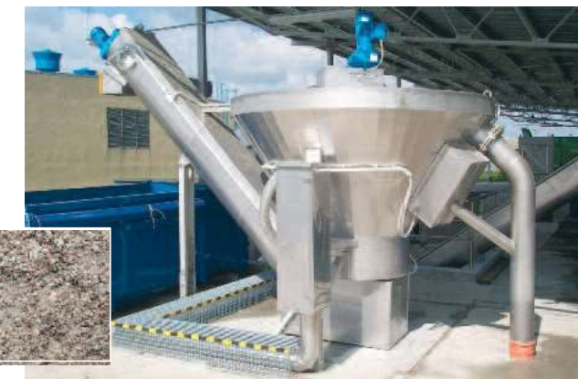
Промит пясък от HUBER Coanda Съоръжението за промиване на пясък RoSF4 със загуба при изгаряне < 3 %, големина на зрънцата до 10мм, СВ > 90
