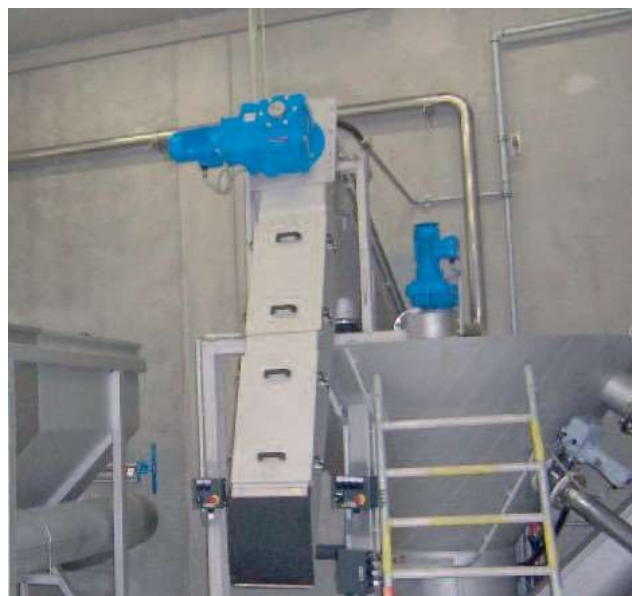
Пример за приложение: Скарен сепаратор над COANDA съоръжението за промиване на пясък
