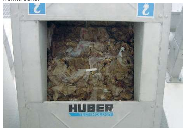
Приложение на HUBER Стъпкова решетка STEP SCREEN® SSF: Много висока експлоатационна стабилност и сигурност спрямо пясък, баластра и камъни благодарение на специално оформеното дънно стъпало за изнасяне наравно с прага на отсятата маса.
