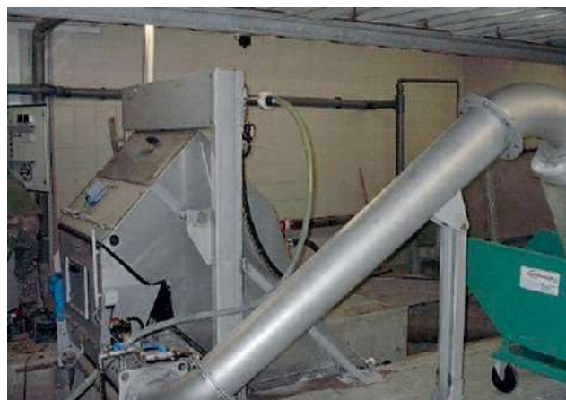
HUBER Стъпкова решетка STEP SCREEN® SSF с HUBER Промивна преса WAP® за оптимални степени на сепарация и обезводняване. За предпазване от корозия изработена от неръждаема стомана и байцвана в пълна вана.
