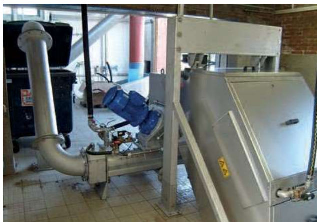
HUBER Стъпкова решетка STEP SCREEN® SSF в комбинация с HUBER Промивната преса WAP® SL за интензивно промиване на отсятата маса в комплектно капсуловано срещу неприятни миризми изпълнение.
