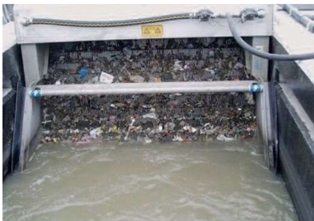
HUBER Стъпкова решетка STEP SCREEN® SSF: дължина 3.500, широчина 1826, процепи 6 мм, ъгъл на инсталация 50 °. Чрез едно-кратното протичане на пресяващата повърхност могат да бъдат реализирани много големи дебети.
