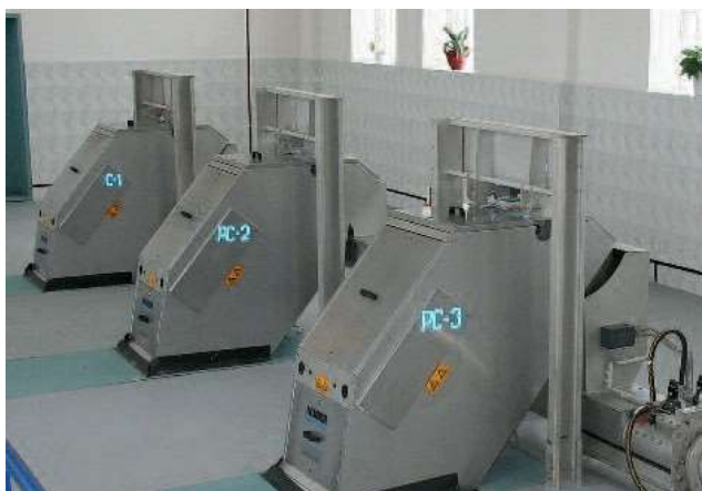
Приложение на HUBER Стъпкова решетка STEP SCREEN® SSF в Русия: Извъртаща се в канал, без да се отстраняват включените след нея HUBER Промивна преса WAP® и HUBER Коритообразен транспортен шнек .
