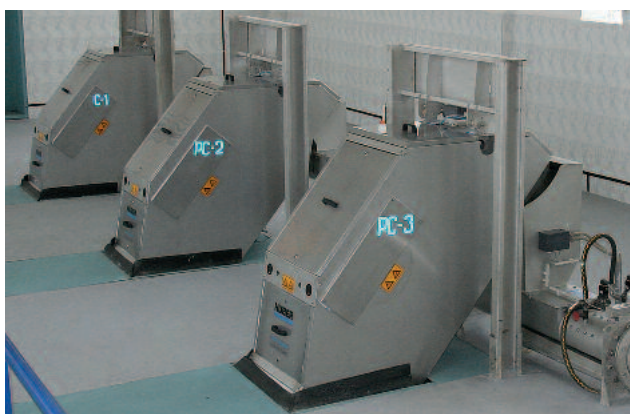
Anwendung HUBER Stufenrechen STEP SCREEN® SSF in Russland: Ausschwenkbar im Gerinne, ohne die nachgeschaltete HUBER Waschpresse WAP® und Huber Trogförderschnecke zu entfernen.
