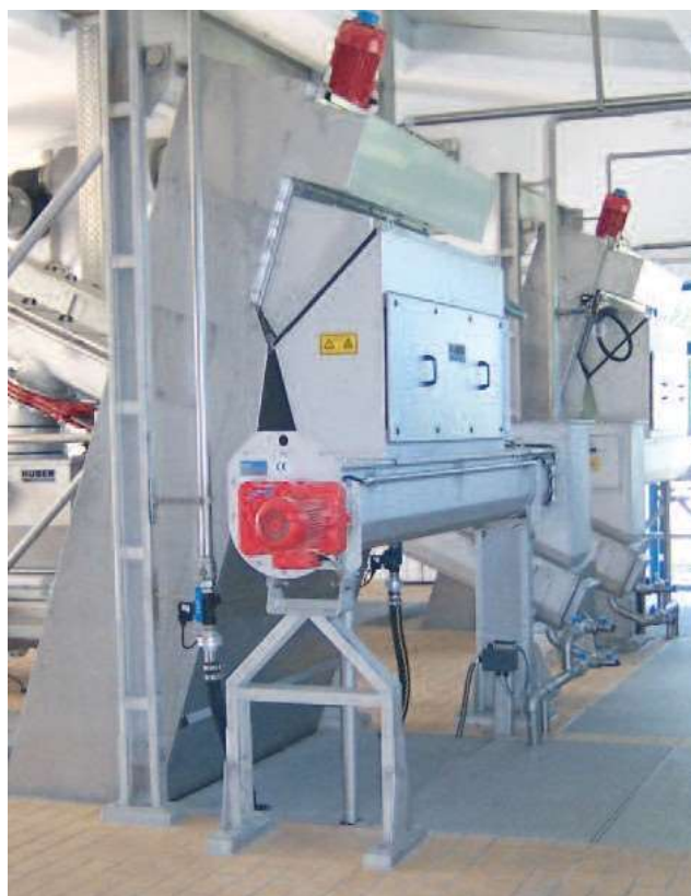
Поглед от страни към HUBER Стъпкова решетка STEP SCREEN® SSV с непрпускаща неприятни миризми предавателна шахта и шнеков транспортър
