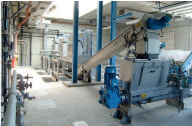
Drei HUBER Stufenrechen STEP SCREEN® SSV: Länge 4300, Breite 1176, Spaltweite 3 mm. Eine optimale Anpassung an bauliche Gegebenheiten (große Abwurfhöhen, tiefe Gerinne) durch steilen Aufstellwinkel zwischen 70-80°.
