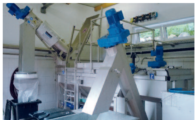
Kompaktanlage mit integriertem Sandwäscher
