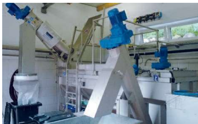
Компактно съоръжение с вграден агрегат за промиване на пясъка
