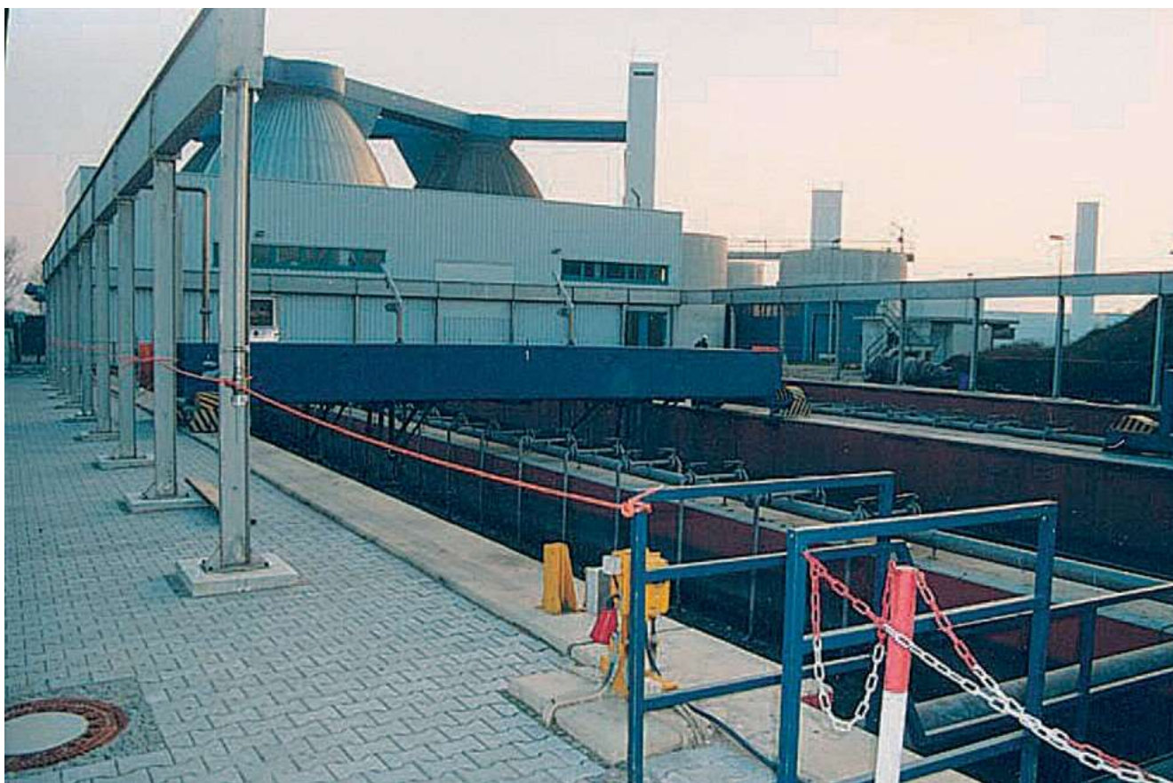
Типичен надлъжен пясъкоуловител със смукателен чистач (ПСОВ Манхайм)
