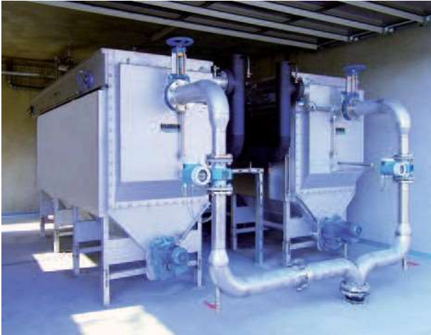
Битова отпадъчна вода; 260kW отоплителна мощност; Отопление на жилищна площ c > 7.000 \text{ m}^2
