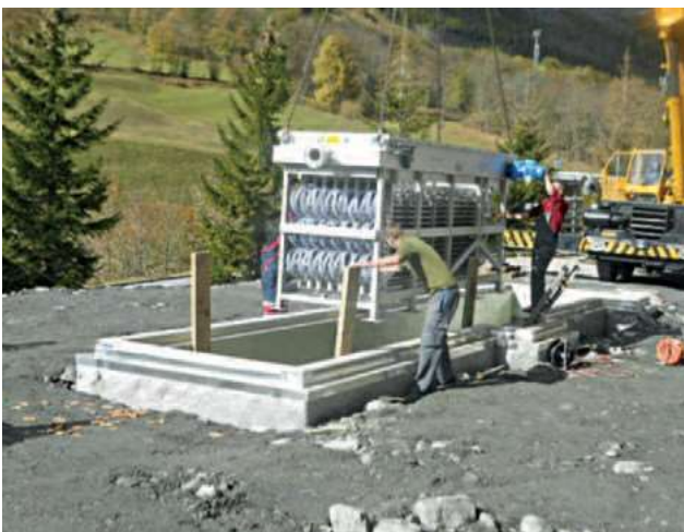
Отпадъчна вода от зала с плувен басейн; капацитет на извличане около 450kW; отопляване на залата с басейна
