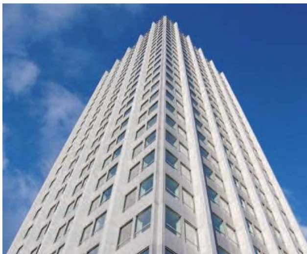
Климатизация на една офис-сграда чрез системата HUBER ThermWin®
