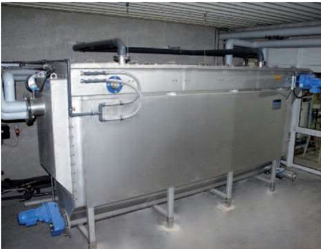
Промислена инсталация; 90kW охлаждаелна мощност със симултантна отоплителна мощност от около 120kW; Приложение за оптимизация на процеса
