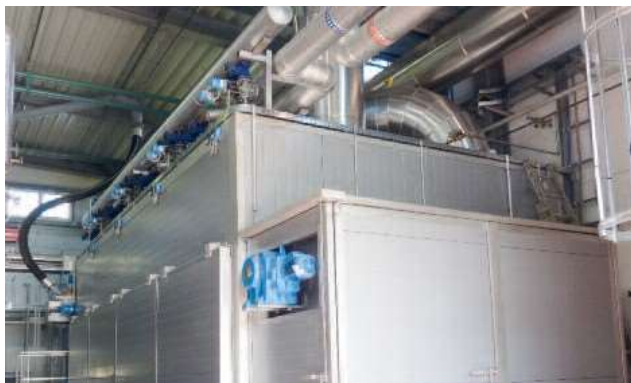
Лентов изсушител HUBER BT за изсушаване на бистри утайки до > 90 % СВ
