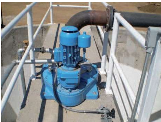
Стабилно задвижване тип Bull Gear за бъркалката
