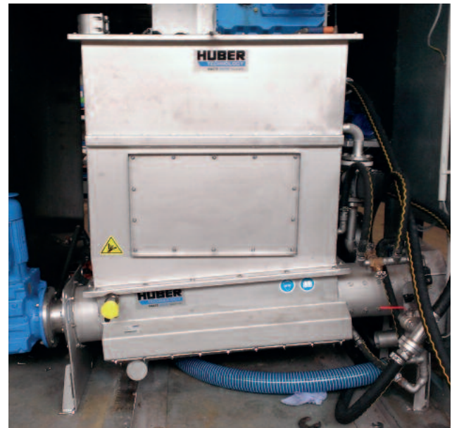
HUBER Waschpresse WAP® liquid mit auswechselbarem Lochblecheinsatz und Lochweiten von 0.75/1/1.5 mm
