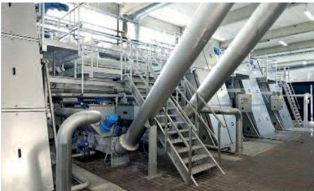
6 Ротационни решетки с кръгли отвори HUBER EscaMax® с промивна преса HUBER WAP-SL за индивидуално напасване пътищата на транспорт чрез гъвкаво водене на водния улей
