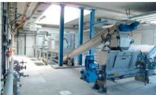
3 стъпкови решетки STEP SCREEN® Flexible SSF с промивна преса HUBER WAP-HP с автоматично регулиран хидравличен агрегат за насрещно налягане за най-високи СВ-съдържания до 60 %.
