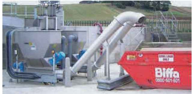
Промивна преса HUBER WAP/SL в изпълнение за работа на открито
