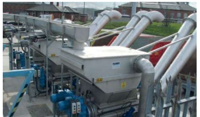
3 промивни преси HUBER WAP-SL с машинна големина 12 с макс. капацитет от по 12 м³/ч със захранване с воден улей. Воден улей с възможна дължина до 40 м.
