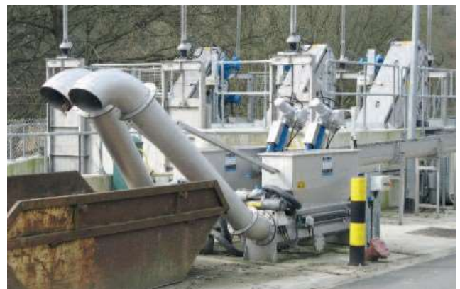
Редундантна експлоатация и оптимално обезводняване на отсятата маса посредством хранване с воден улей
