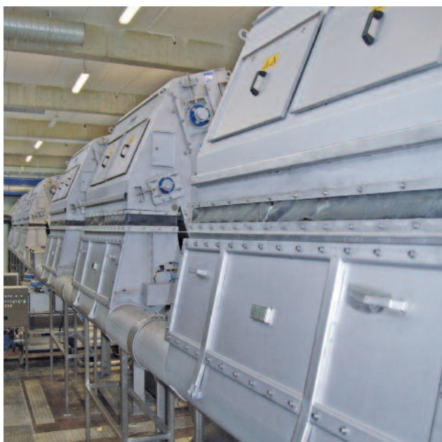
Rückansicht des HUBER Lochblech-Umlaufrechen EscaMax® mit nachgeschalteter Schwemmrinne für verschleißfreien Rechenguttransport
