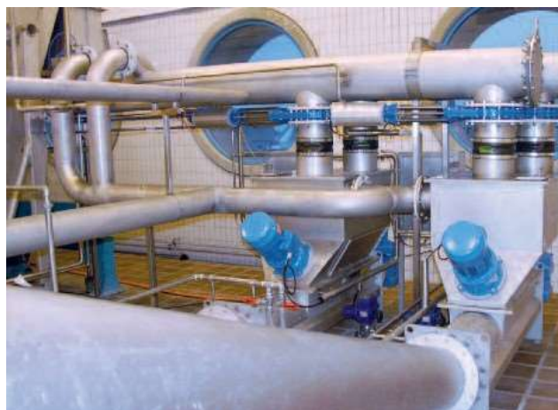
Редувантно захранване с воден улей на HUBER Промивни преси WAP® SL
