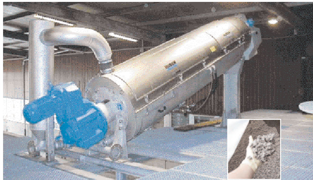
Обезводняване на флотатна утайка с HUBER ROTAMAT® RoS 3 – на малката снимка: обезводнена флотатна утайка със съдържание на СВ > 30 %
