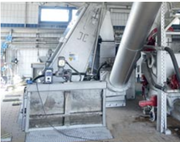
HUBER Harken-Umlaufrechen RakeMax® CF ein universell einsetzbarer Rechen, sowohl für Bestands- wie auch für Neubauten
