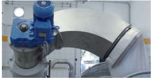
Индивидуално напасване към съществуващите условия напр. чрез странично изнасяне на отсятата маса с разтоварване директно в контейнер
