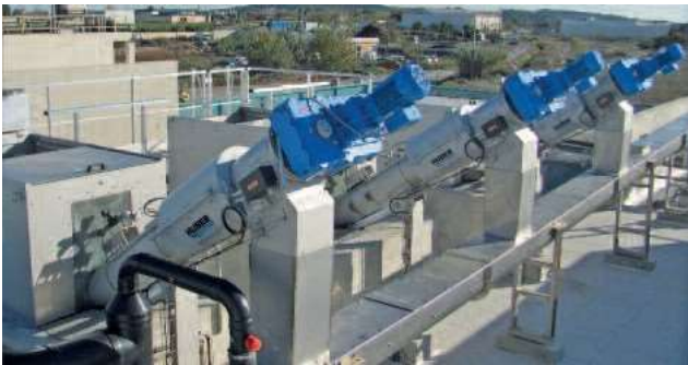
3 x ROTAMAT® STAR машинна големина 1000 с 1,5 мм диаметър на кръглите отвори за предпазване на включено след това мембранно съоръжение
