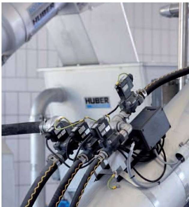
HUBER Сито ROTAMAT® с вградена промивка на отсятата маса IRGA
