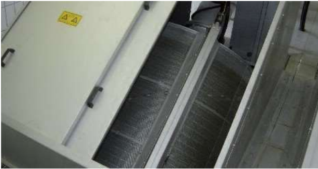
Монтаж в канал на HUBER Cito ROTAMAT® с избутващо се покритие от неръждаема стомана – машинна големина 600 до машинна големина 3000
