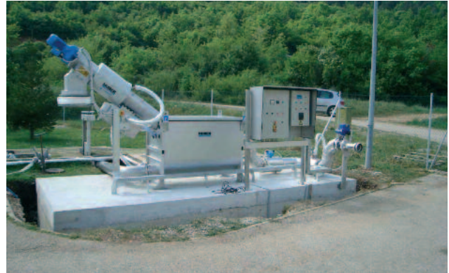
Bewährte Vorreinigungskomponenten vereint in der ROTAMAT® Fäkalannahmestation Ro 3.3.
