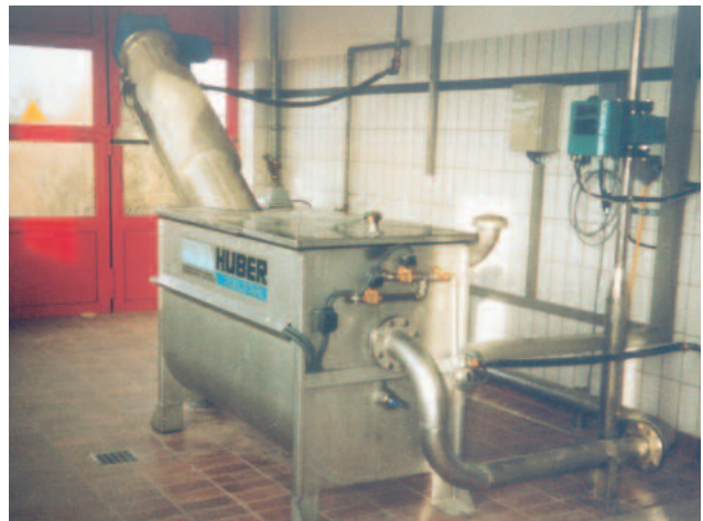
ROTAMAT® Fäkalannahmestation Ro 3.1 mit ROTAMAT® Feinstreichen
