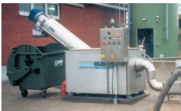
ROTAMAT® Fäkalannahmestation Ro 3.1 mit ROTAMAT® Feinstrechen in beheizter und isolierter Ausführung
