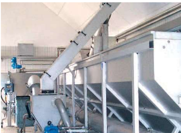
Интензивно промиване на отсятата маса с WAP/SL след едно HUBER Компактното съоръжение ROTAMAT® Ro5
