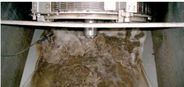
Доказало качествата си най-фино прецеждане на отпадъчните води посредством HUBER Сито ROTAMAT® Ro2
