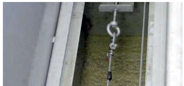
Греблото за мазнини работи по принципа на един надлъжен чистач, който прибутва изплаващата мазнина в помпения приемник.
