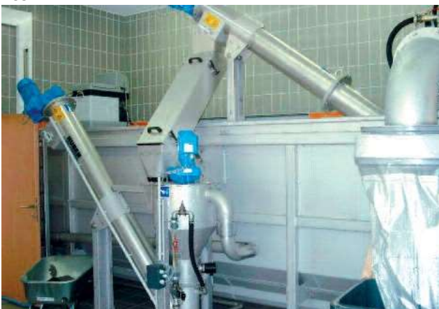
Класифициращ шнек с включено след това ХУБЕР съоръжение за промиване на пясък RoSF4 TC
