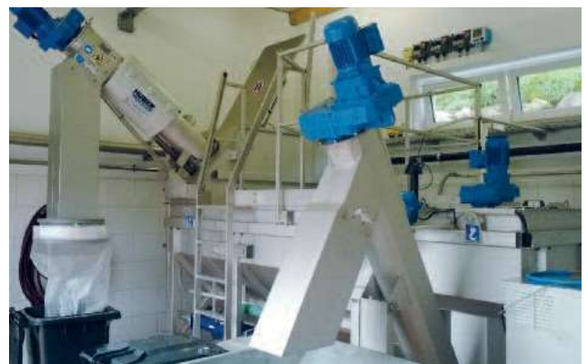
Компактно съоръжение с вградено устройство за промивка на пясъка
