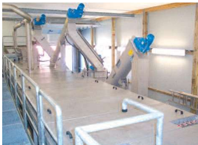
Чисто изнасяне на отсята маса и пясъчен пулп при HUBER Компактното съоръжение ROTAMAT® Ro5
