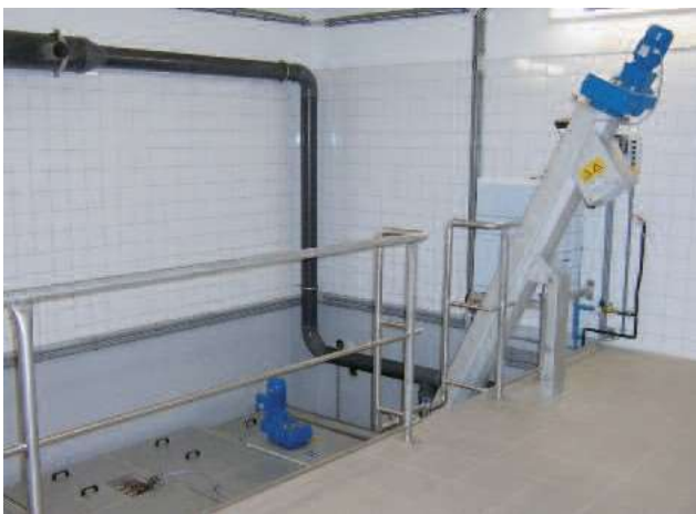
Вградена промивка на пясъка в края на HUBER Компактното съоръжение ROTAMAT® Ro5
