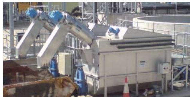
Инсталирани в резервоари фино сита ROTAMAT® Membrane Screen RoMem
