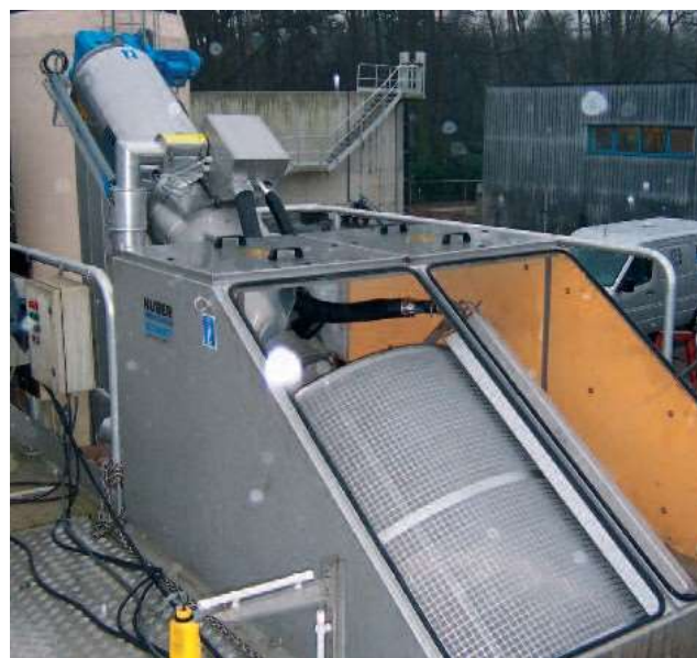
Инсталация на открито с покритие и термоизолиран тръбопровод за пръсканата вода
