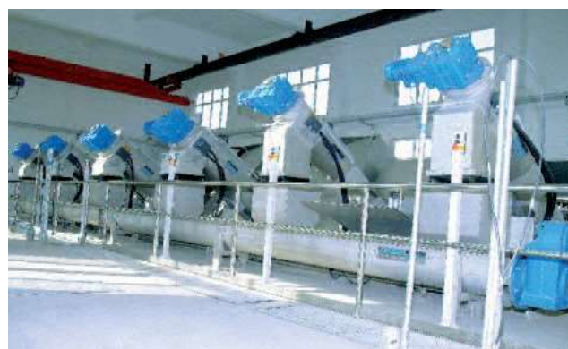
Инсталирано сито ROTAMAT® Membrane Screens RoMem за защита на една голяма мембранна активираща инсталация
