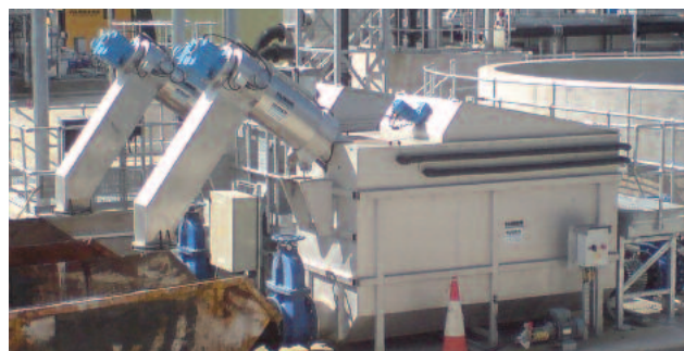
In Behältern installierte Feinstsiebe ROTAMAT® Membrane Screen RoMem
